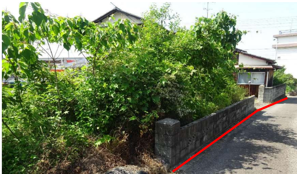
対象不動産の南東側より撮影
