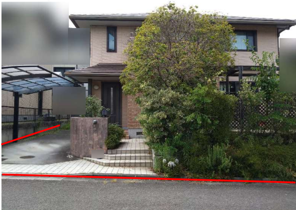
対象不動産の南東側より撮影
