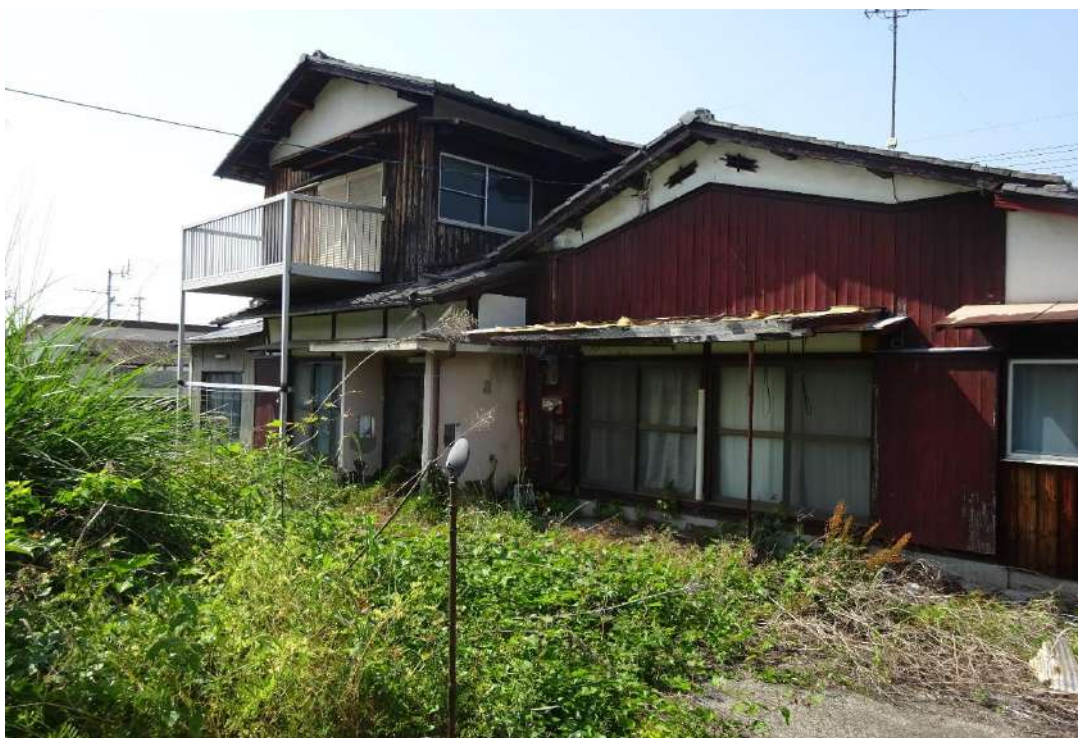
対象不動産の南東側より撮影
