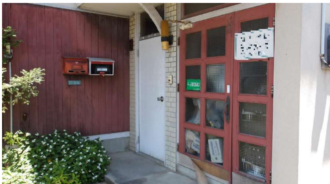
対象不動産の玄関前
