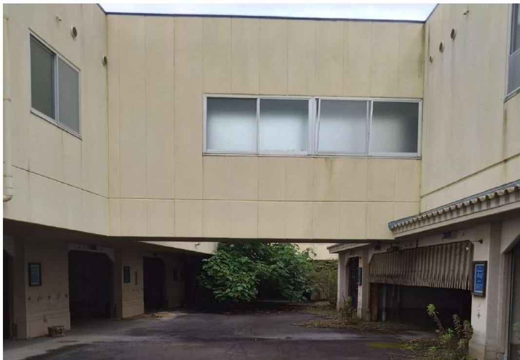
対象不動産内部の南側より撮影
