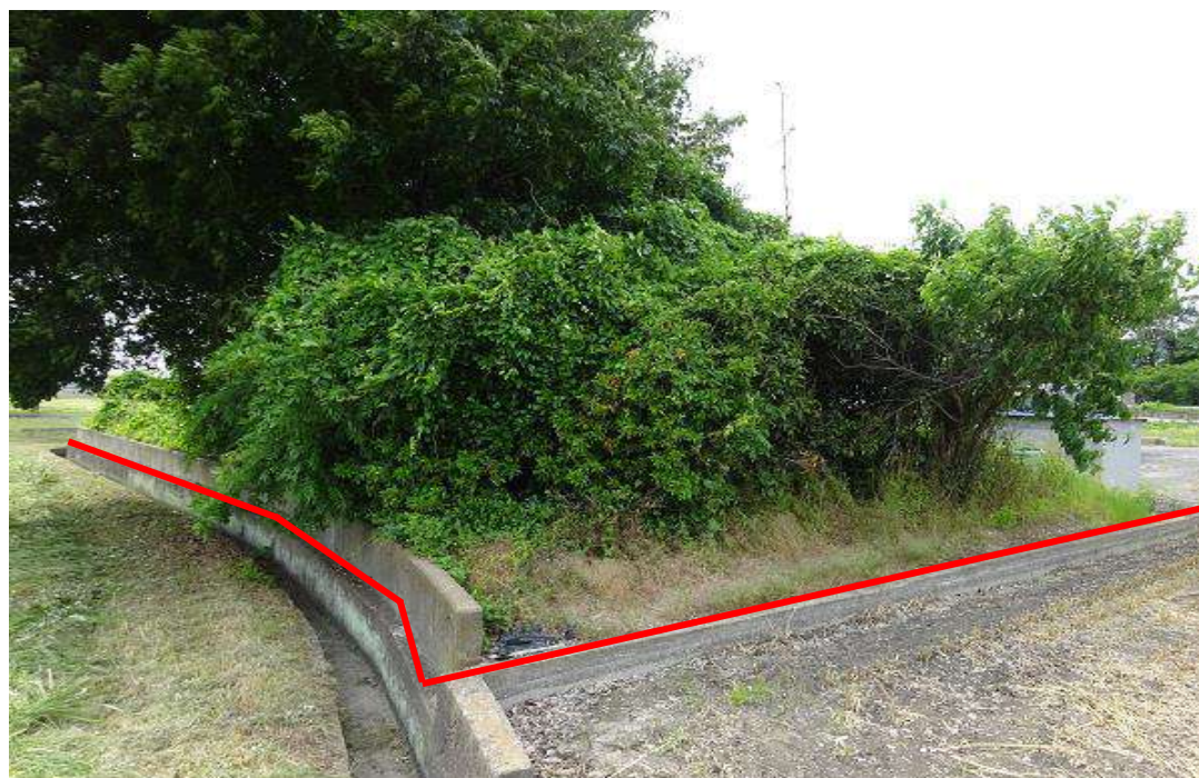
対象不動産の南東側より撮影
