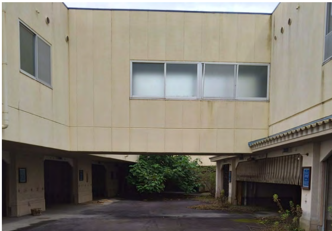
対象不動産内部の南側より撮影
