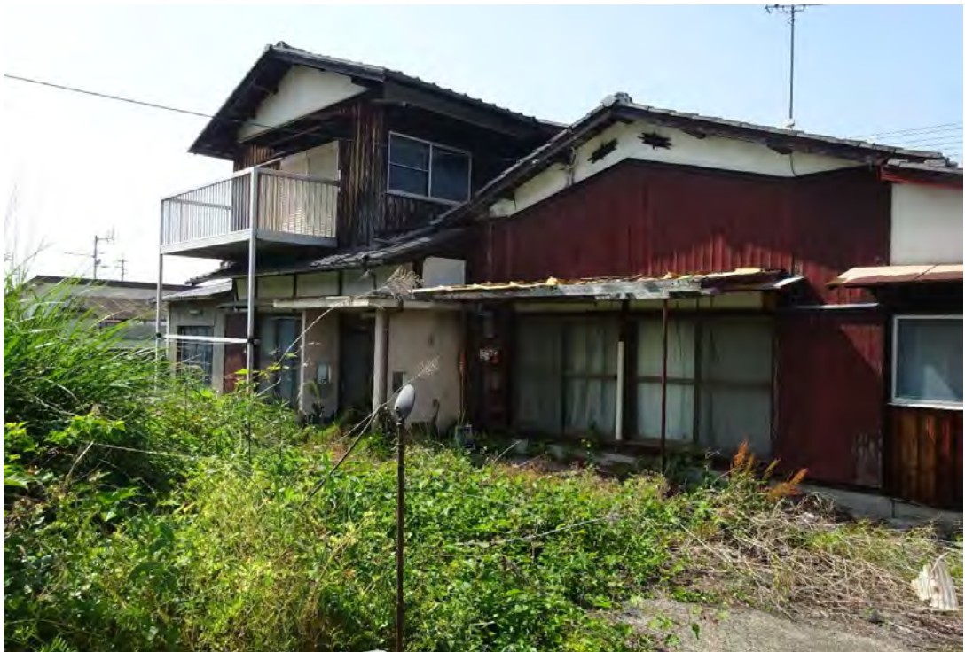
対象不動産の南東側より撮影
