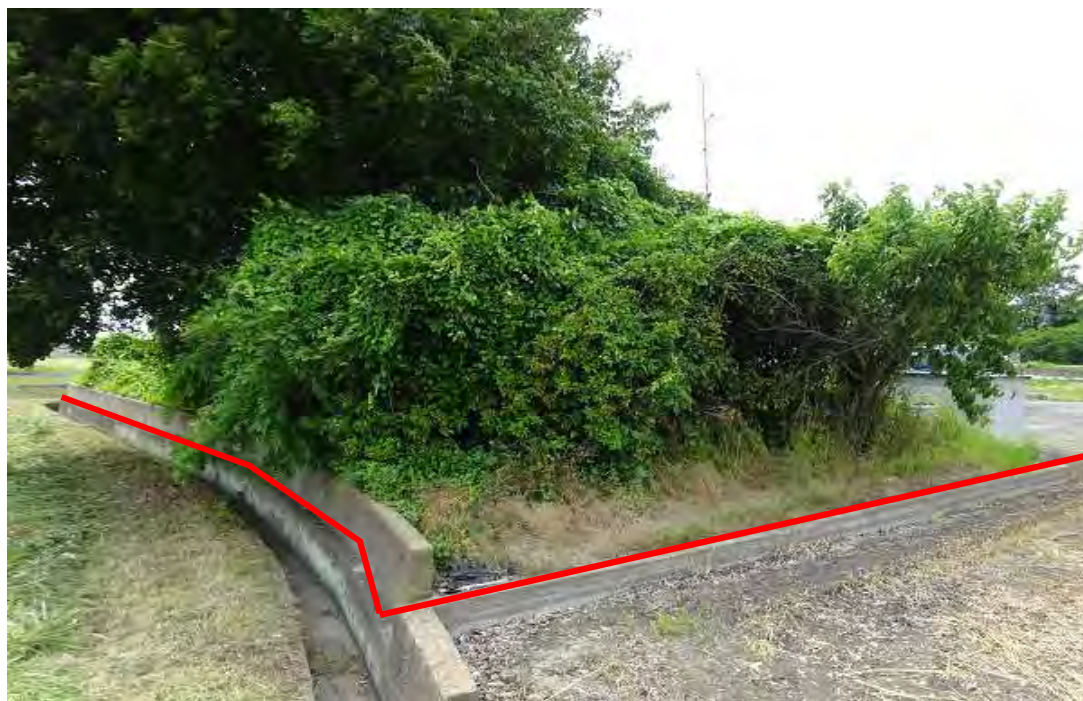
対象不動産の南東側より撮影
