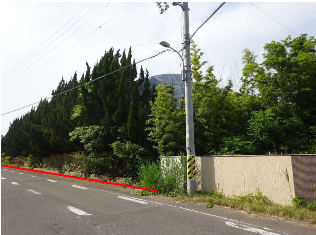
対象不動産の南西側より撮影
