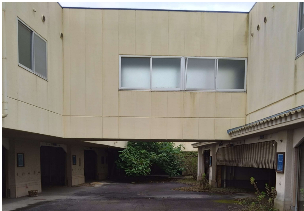
対象不動産内部の南側より撮影
