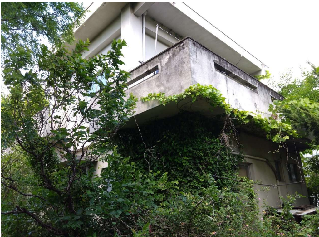
対象不動産の西側より撮影
