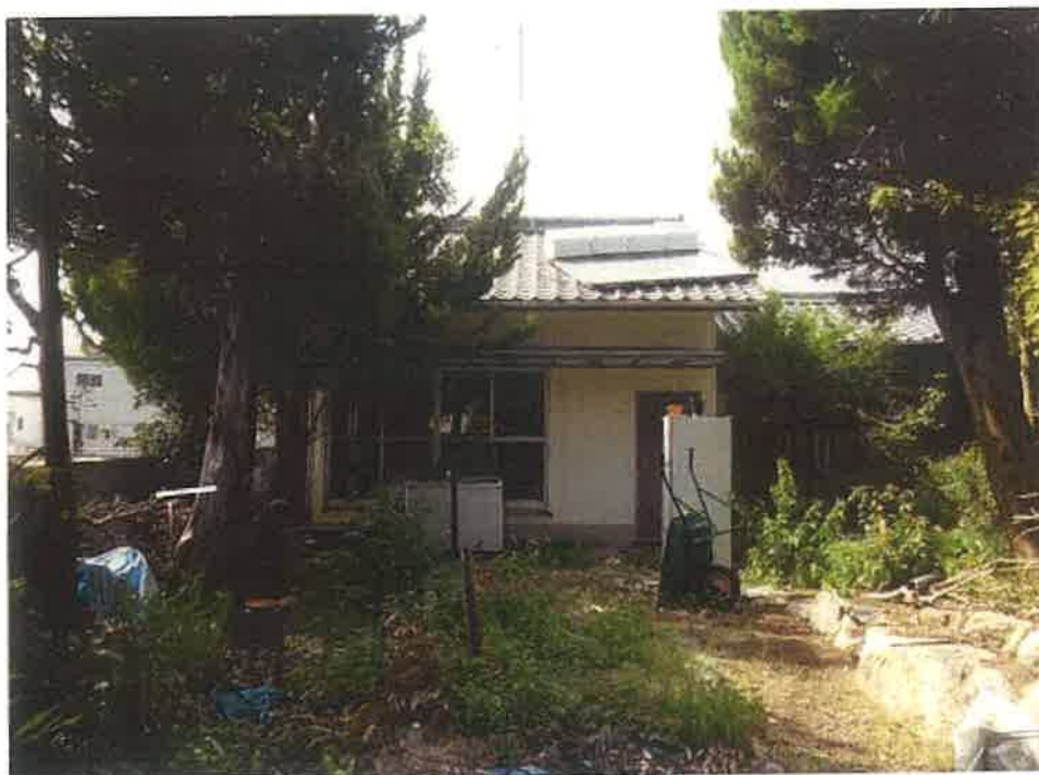
対象不動産の南東側より撮影
