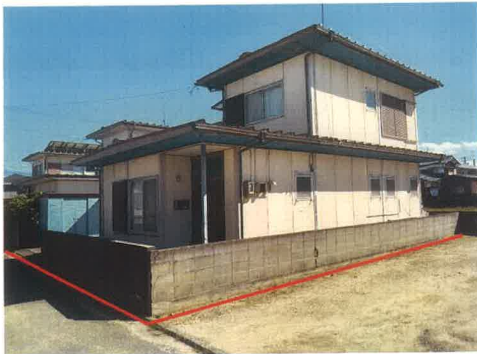
対象不動産の北側より撮影
