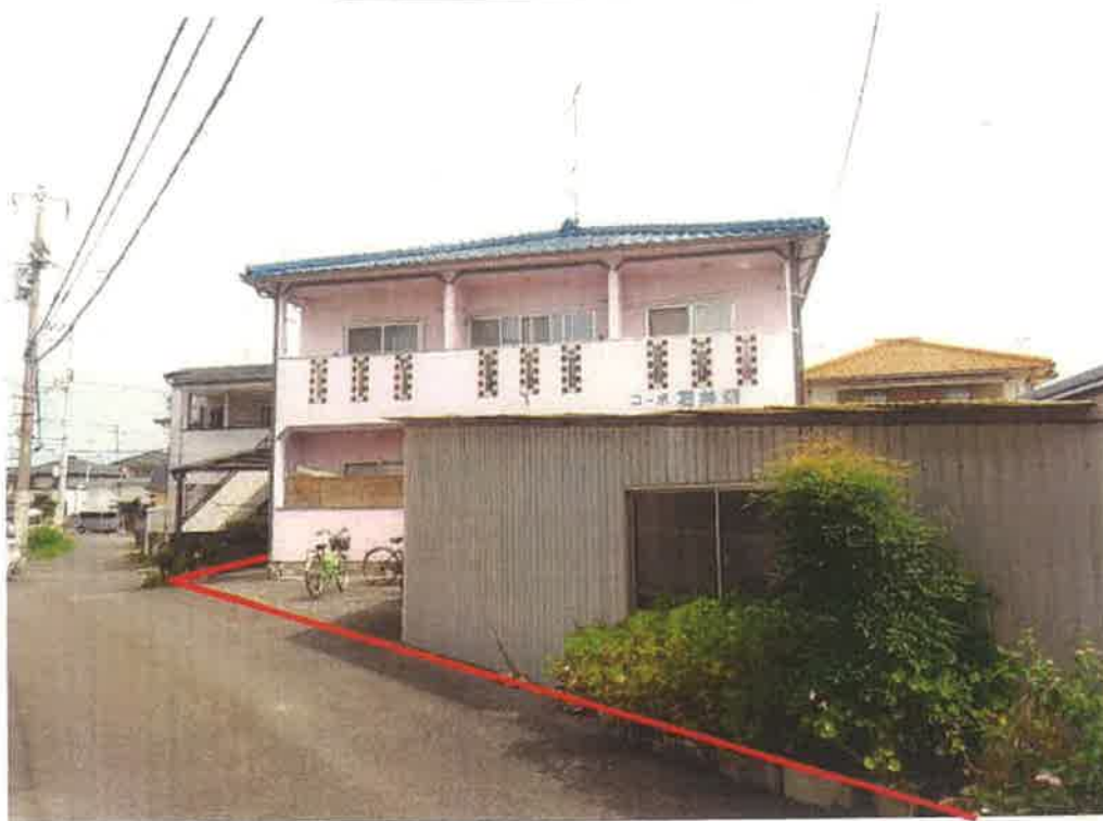
対象不動産の南側から撮影
