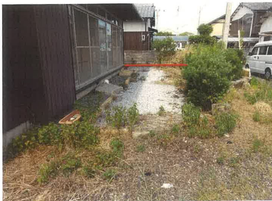
対象不動産の南西側より撮影
