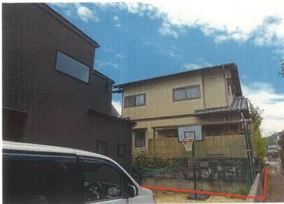
対象不動産の北側より撮影
