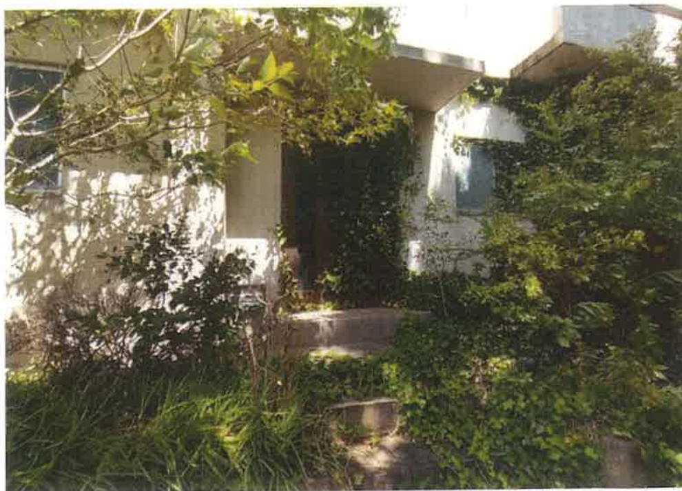
対象不動産の玄関前
