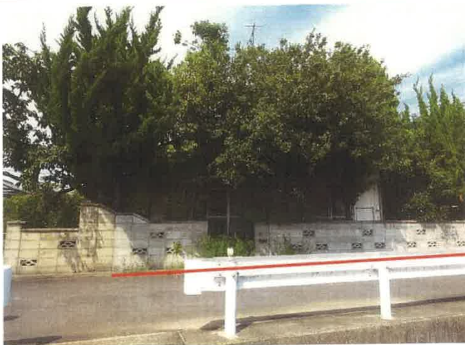
対象不動産の南西側より撮影
