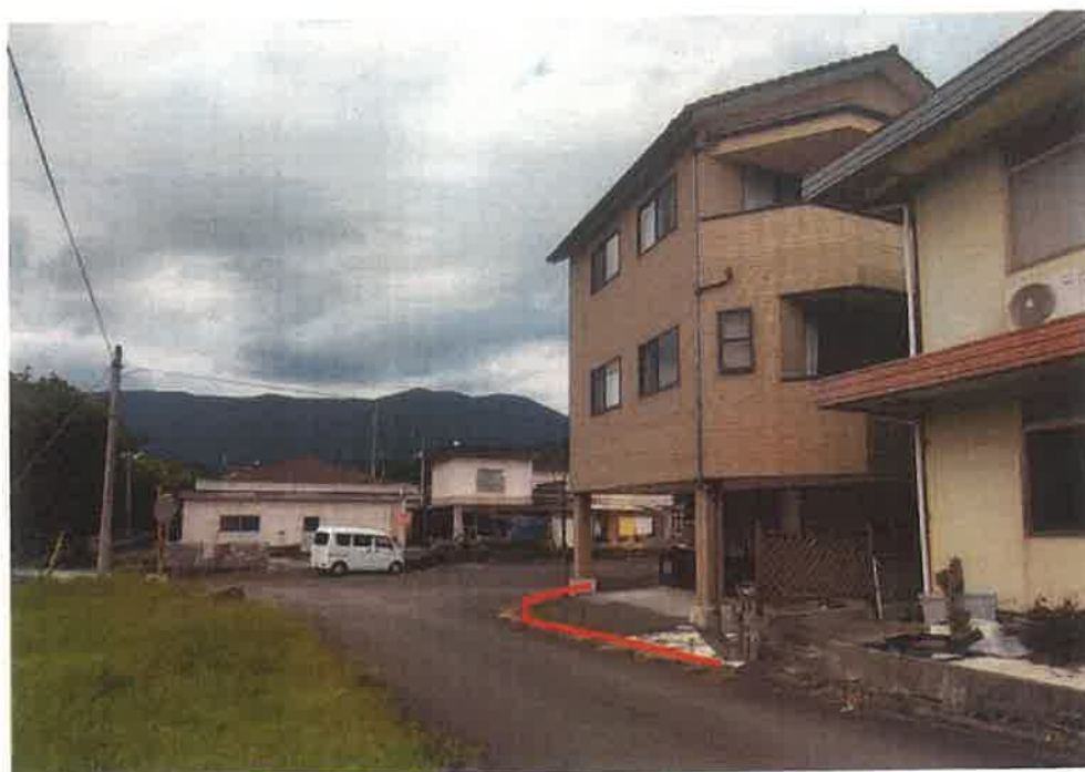
対象不動産の南西側より撮影
