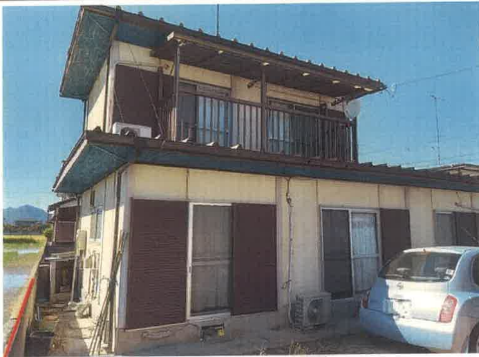
対象不動産の南東側より撮影
