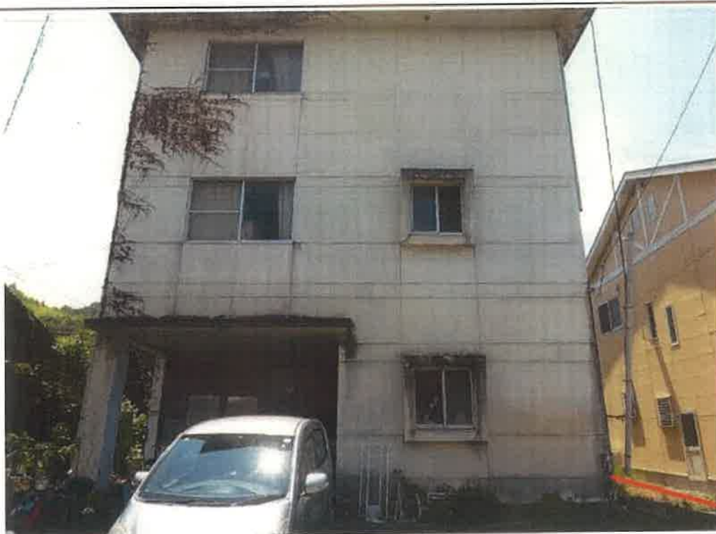
対象不動産の北側より撮影
