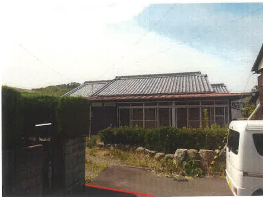
対象不動産の南東側より撮影
