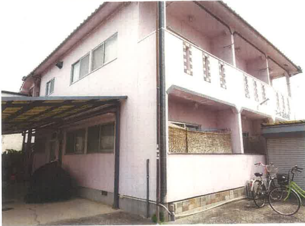
対象不動産の南西側より撮影
