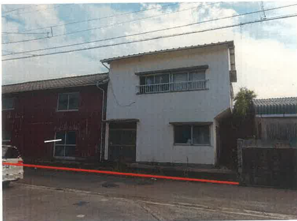
対象不動産の北側より撮影
