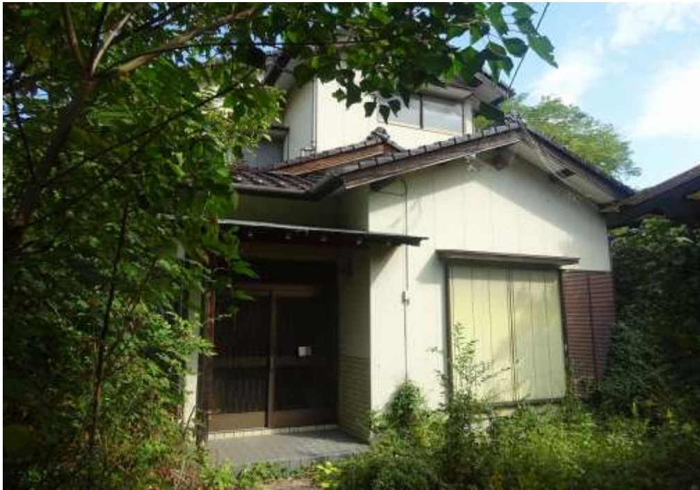
対象不動産（居宅）
