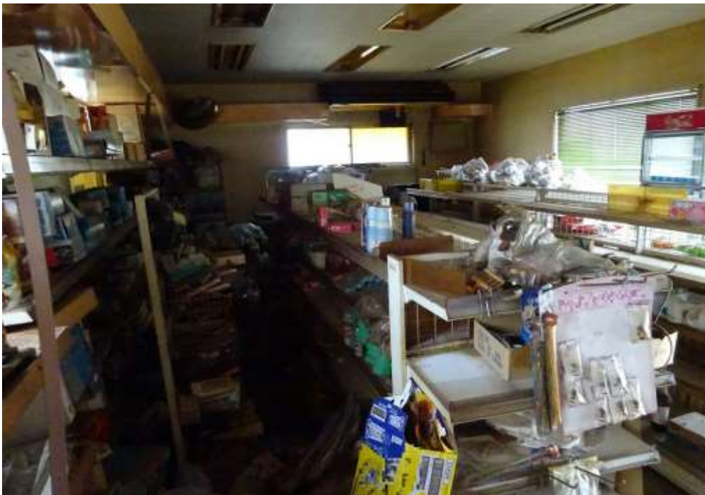
対象不動産（建物内入口から東部分）の 西側より撮影
