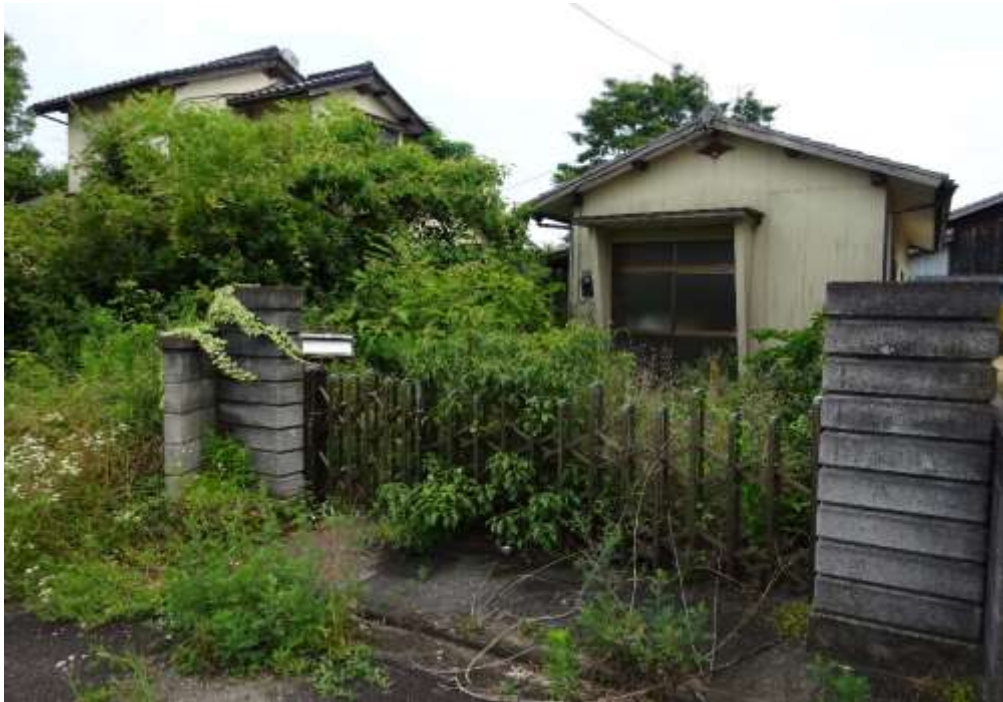
対象不動産の北側より撮影
