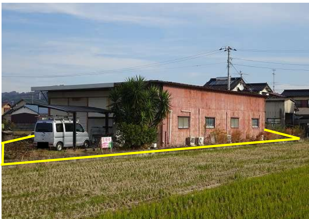
対象不動産の南西側より撮影
