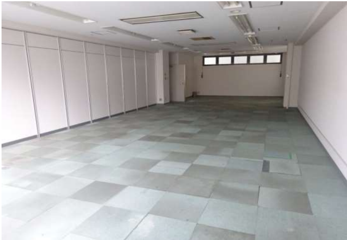
対象不動産（建物3階東側の部屋）の南側より撮影
