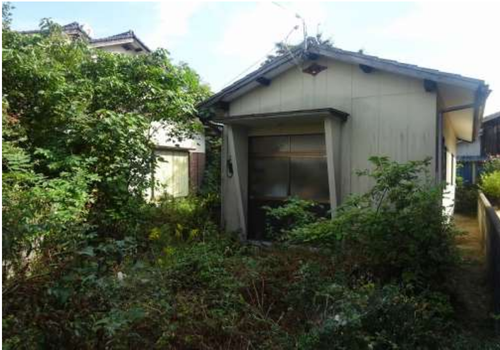
対象不動産（倉庫正面から）
