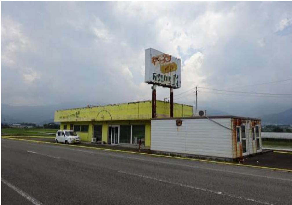
対象不動産の南東側より撮影
