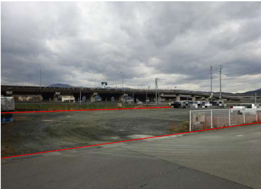
対象不動産の南東側より撮影
