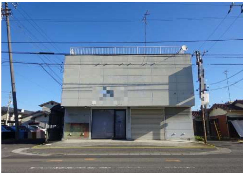
対象不動産の南西側より撮影
