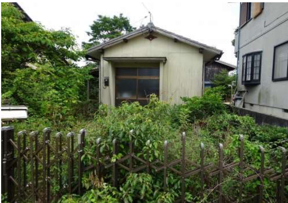
対象不動産の北側より撮影
