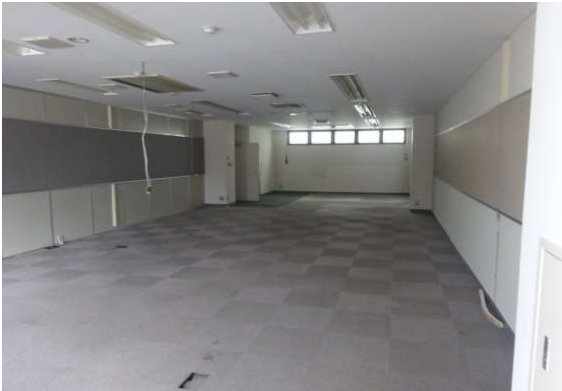
対象不動産（建物4階東側の部屋）の南側より撮影
