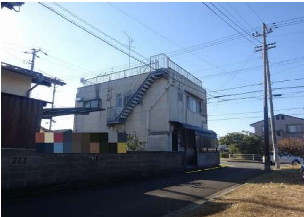
対象不動産の北側より撮影
